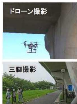
ひび割れ撮影
