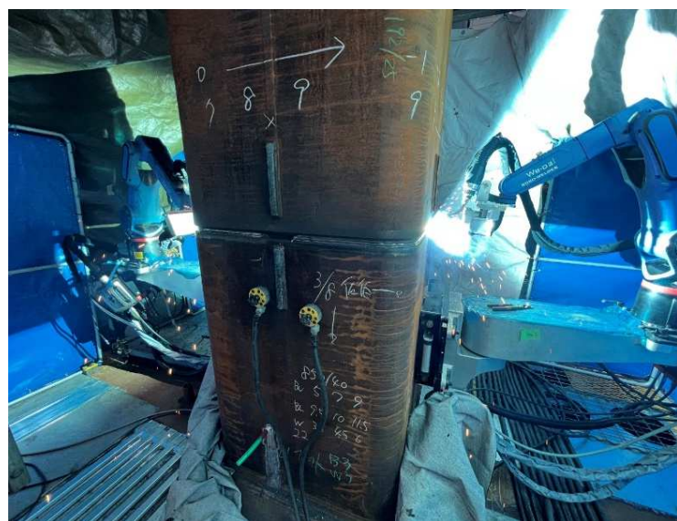
〈溶接ロボット Robo-Welder〉
