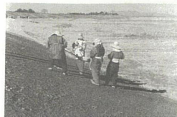
『タコつきによる締固め』（～昭和30年代） 重さ10～15kgの石ダコを6～8人掛で引張り上げた後に落下させて締め固める
