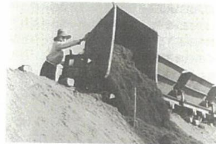
『撒き出し』（大正～昭和30年代） 機関車を用いて土を運搬する場合、特に締固めは行わなかった
