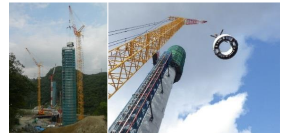
クレーンで吊り込み設置
