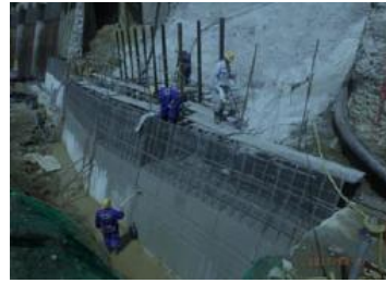
擁壁工 外壁の埋設型枠
