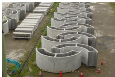
工場から現地に搬入
