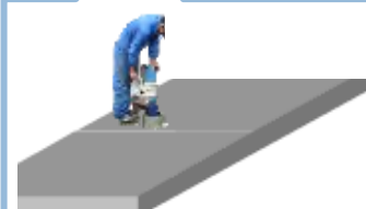
コア抜きによる検査
