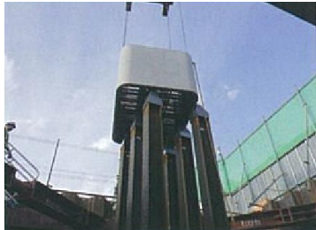
橋梁下部工 橋脚部の埋設型枠
