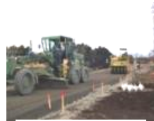
丁張りに 合わせ施工
