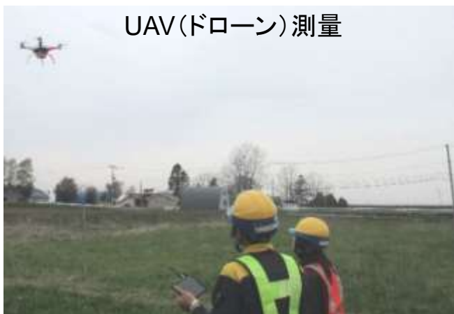
(道央圏連絡道路 泉郷改良工事)
