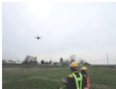
UAVによる施工前の測量
