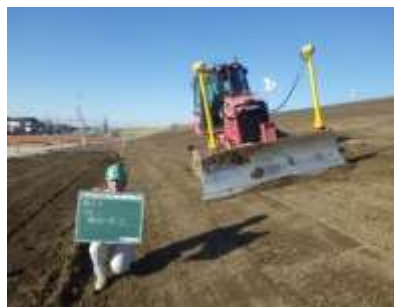
MCブルドーザ法面整形
