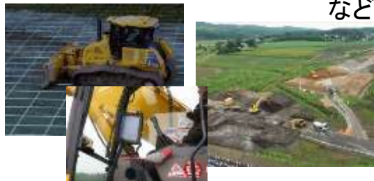
ICT建機での施工
