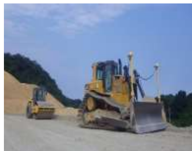
MCブルドーザ敷均し
