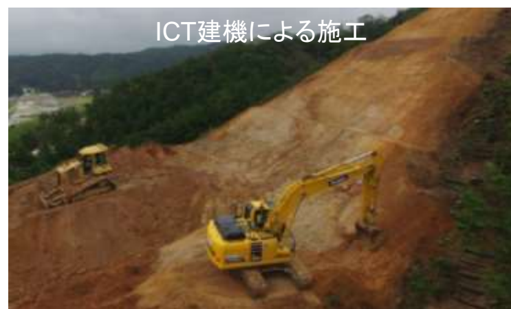
(鳥取西道路重山第3改良工事)
