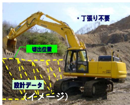
▲マシンコントロールバックホウ技術
