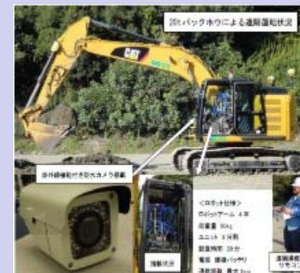
▲災害応急復旧ロボット(無人化施工57)
