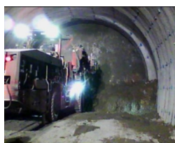
写真-10 鏡吹付け施工状況
