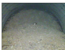
写真-1 発破後の切羽
