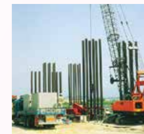
【鉄骨の建込み】
