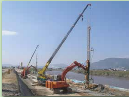
ロッド継足しによる施工
