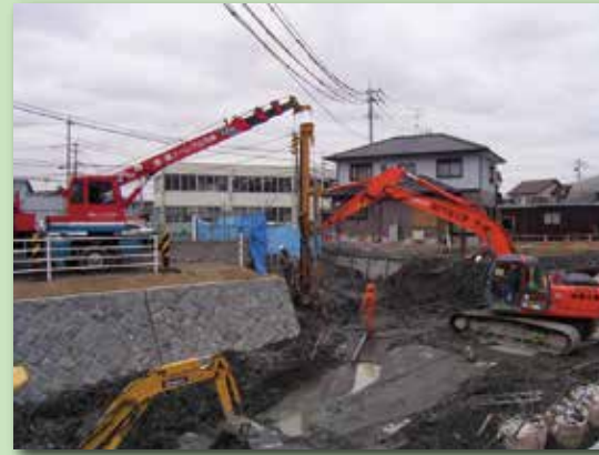
空頭制限下での施工
