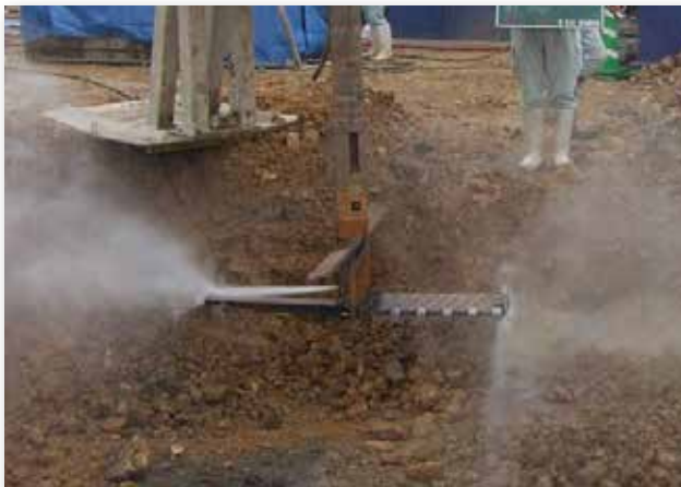
【攪拌翼のモデル図および写真】
