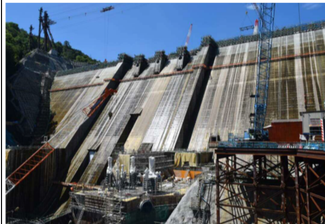
【ダム全景 平成30年7月撮影】
