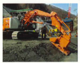
④端部締固機 内部コンクリートの端部を締めます。
