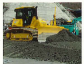
②ブルドーザー 厚さ25cm程度に敷きならします。4回くりかえし、1mの厚さにします。
