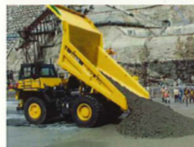
①ダンプトラック コンクリートを打設現場まで運搬します。
