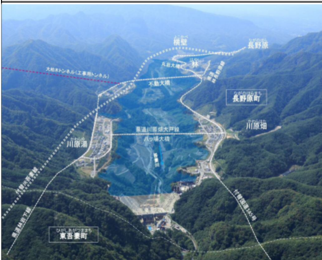
【貯水池全景 平成29年10月撮影】
