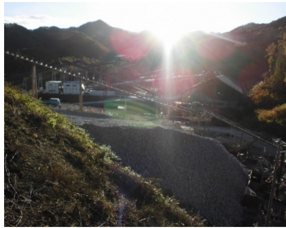
原石山骨材製造設備
