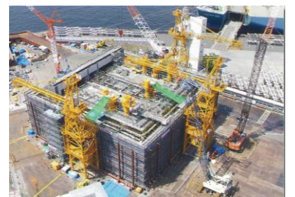
接続部(ニューマチックケーソン)築造
