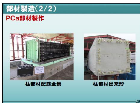
PCa部材の製作
