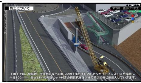
図-3 工事概要 道路切り回し(蓋掛け工) 建設DX取組み例:3次元BIM/CIM
