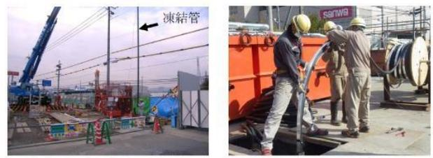
従来工法 鋼管機械建て込み(溶接) → ICECRETE フレキシブルICチャンネル(連続)
