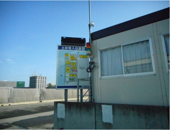
ETCシステムによる土砂荷下し場所の管理状況
