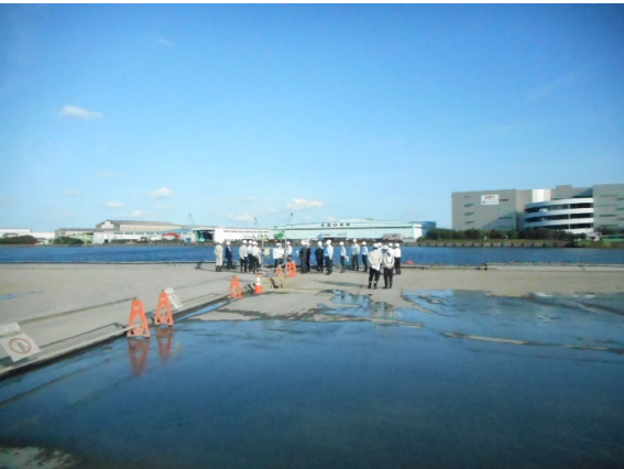
大型船舶の離着岸用岸壁
