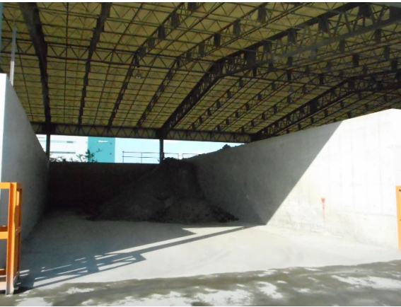
土砂保管場所
