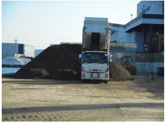
建設発生土 受入れ状況
