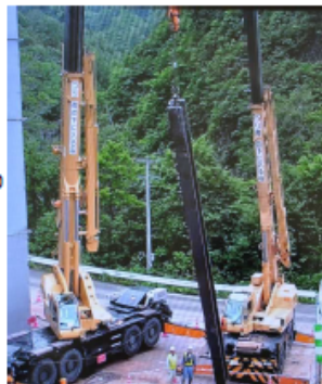
③ 建て起こしクレーン2台
