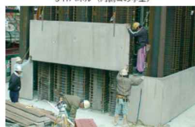
鹿児島県3号第2号橋下部工での適用状況
