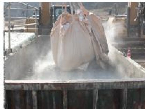
③固化材の投入・攪拌
