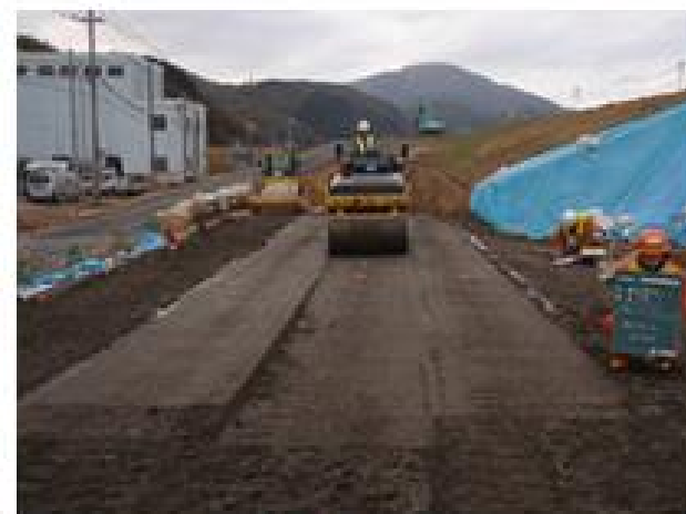
⑥改良土の転圧
