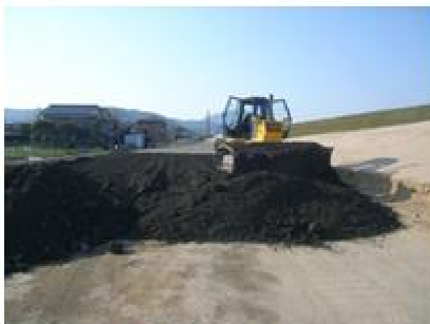
⑤改良土の敷均し
