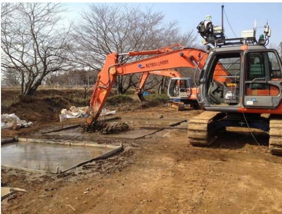
攪拌状況（スケルトンバケット）
