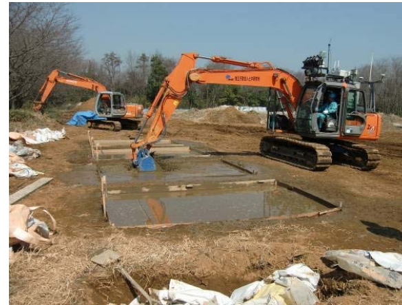
攪拌状況（パドル付バケット）
