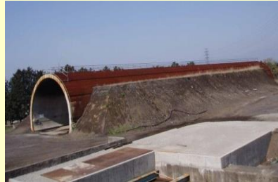
施工総研内模擬トンネル (静岡県)
