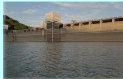
宮ヶ瀬ダム(神奈川県)
