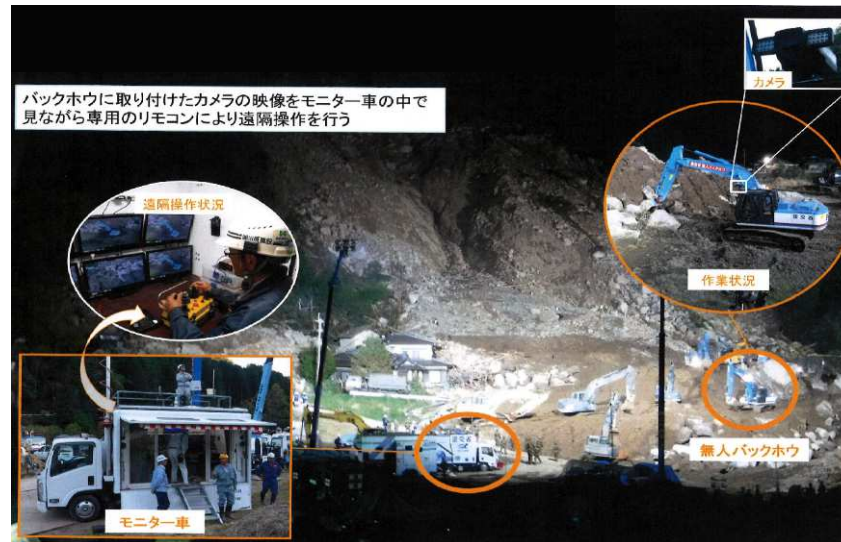
無人化施工方式 第2世代の操作状況(耶馬溪災害復旧より)
