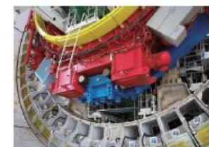
セグメントを組み立てるエレクター
