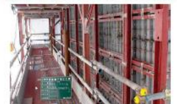
鋼製型枠(洞泉橋下部工工事)
