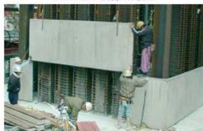
鹿児島3号架り2号橋下部工での適用状況
