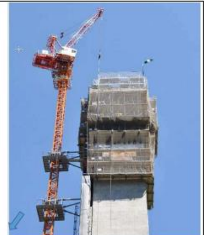
国道289号5号橋梁下部工その2工事での適用状況
