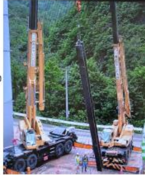
③ 建て起こしクレーン2台
