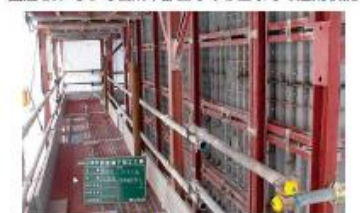
鋼製型枠(湧泉橋下部工工事)
