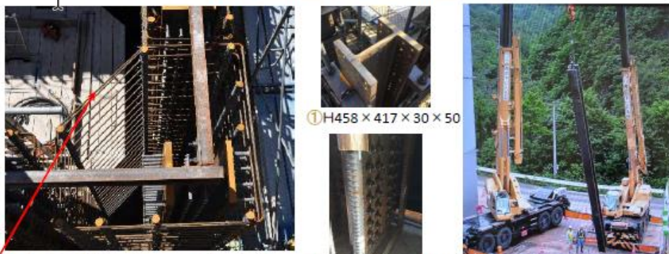
隅角部補強鉄筋(5角形):平成24年度道示改定 ②添接板とボルト ③建て起こしクレーン2台
