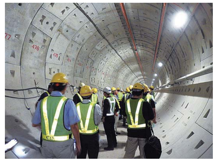
施工が進む「ブルーライン」のトンネル内
